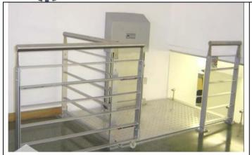
Sistema elevación para personas, tipo elevador o plataforma, electro-hidráulico, altamente confiable, bajo consumo de energía, 110/220 voltios. Fácil instalación, no requiere obra civil, adecuado para hogares, locales comerciales, oficinas, bodegas.
